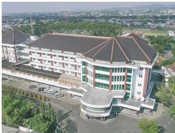
Gambar 2. 1 Gedung RSU UMM
