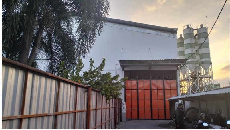
Gambar 2.5.4 Bangunan Pabrik PT. Alfa Viktori Familia
