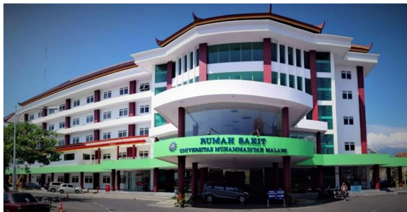
Gambar 2. 1 Gedung RSUD Universitas Muhammadiyah Malang
