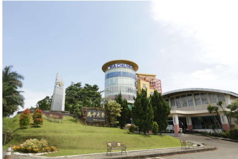
Gambar 2.1 Gedung Universitas Ma Chung (Sumber: Foto Pribadi)
